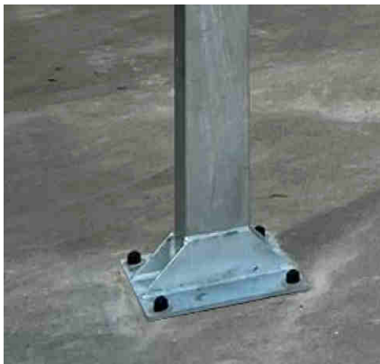
Detalle de la placa de anclaje
